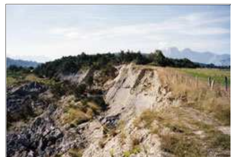
Glissement de terrain de l'Harmalière (actif) sur la commune de Sinard (Trièves, Isère) - © S. Gomet (IRMa)
